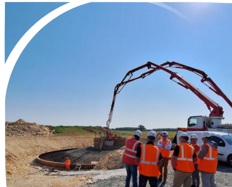
Visite du chantier du parc éolien de La Chapelle-Bâton
