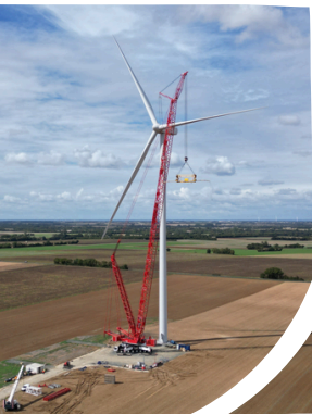
Construction parc éolien de Chambon Puyravault
